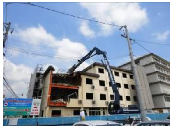
芦辺寮解体の様子
